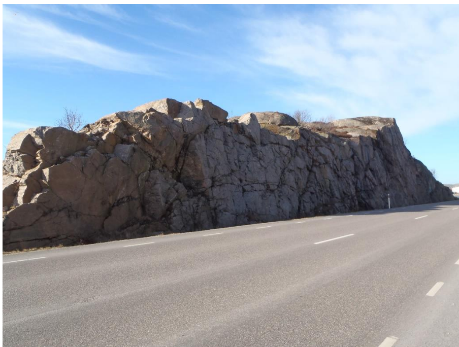
Figur 4.5. Den västra bergskärningen, vy mot norr.
